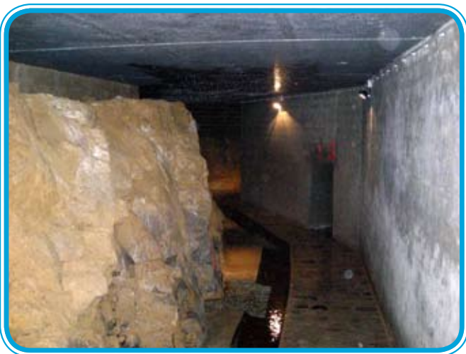
Quellfassung / Source Contern
